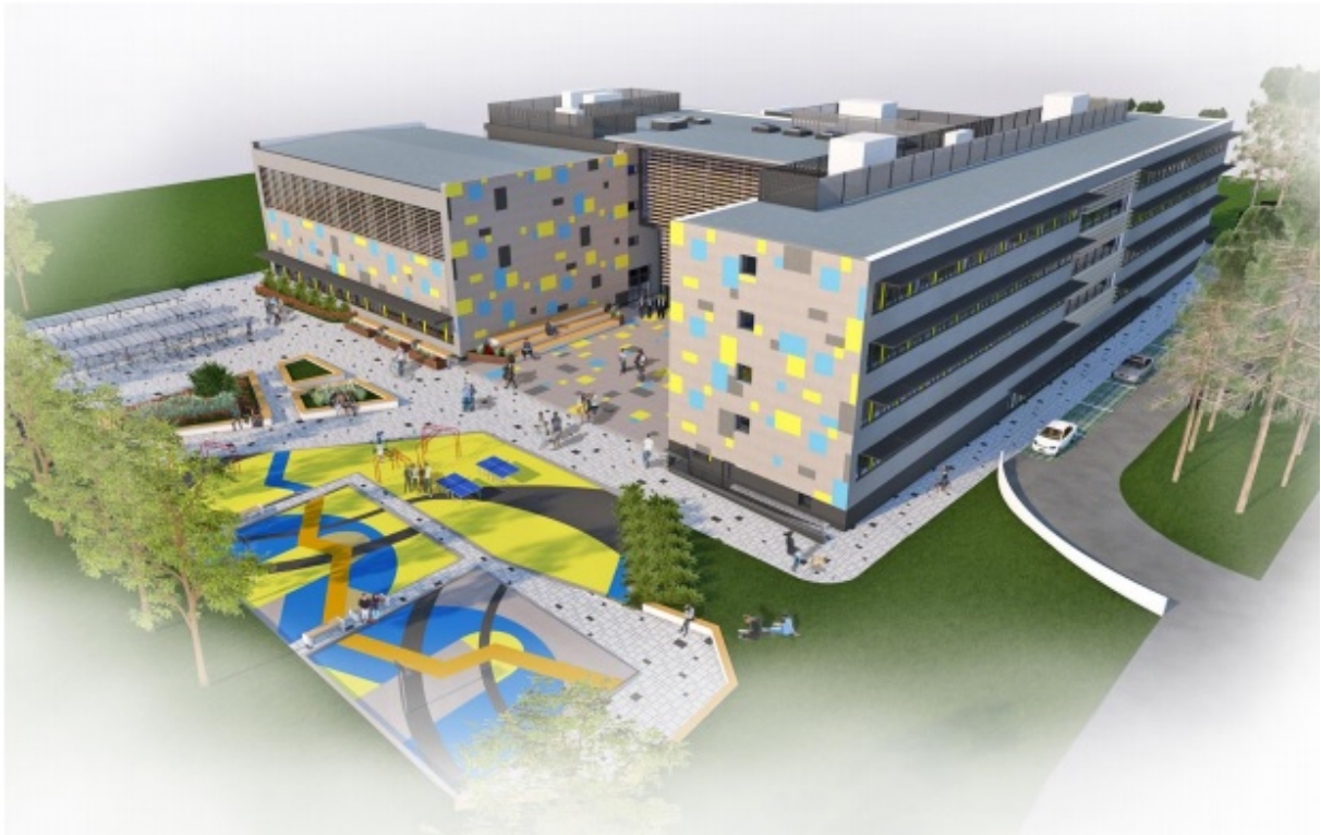
Blick auf die renovierte Schule aus der Vogelperspektive
